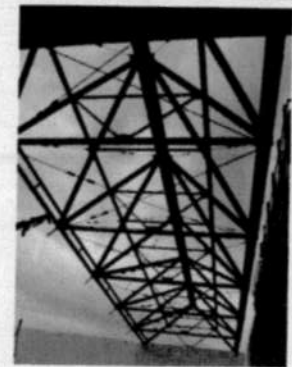
Travi reticolari in acciaio della copertura
