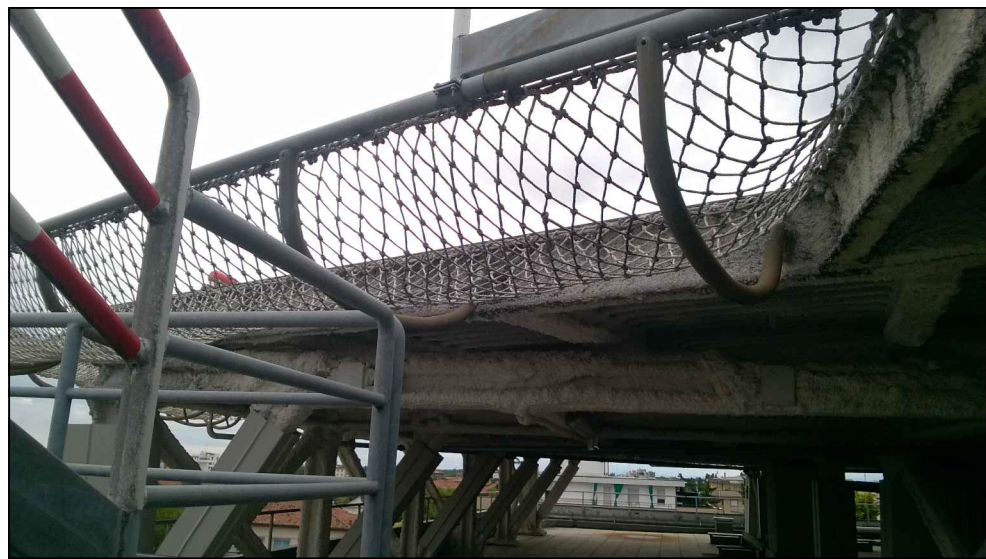
PARTICOLARE RETE E TRAVI AGGANCIO CANALA IMPIANTI
